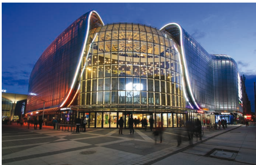
Katowice Gallery, Polen Entwurf / SUD ARCHITECTES
